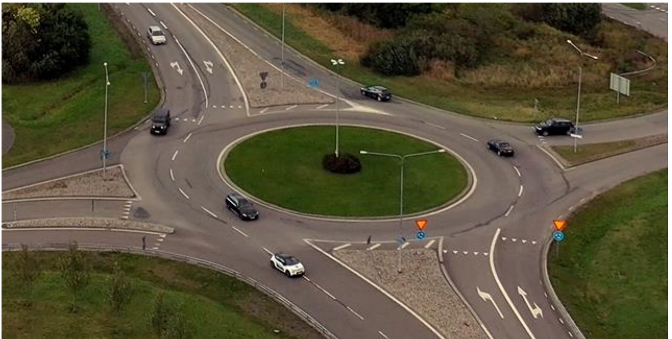
Exempel på drönarfilmning (utförd av WSP) över typisk flerfältig cirkulationsplats där vissa körfält enbart leder mot avfart (dvs. är som Exempel 2 ovan).
