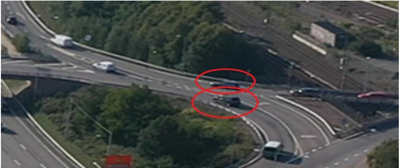
Drönbild över den nordvästra delen av Munkebäcksmotets cirkulationsplats (norr är åt höger i bild). Nedan texter hänvisar till denna bild.
