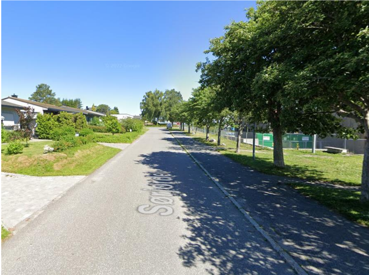
FIGUR 6: EKSISTERENDE FORTAU LANGS SØRJORDET (GOOGLE MAPS, 2022)
